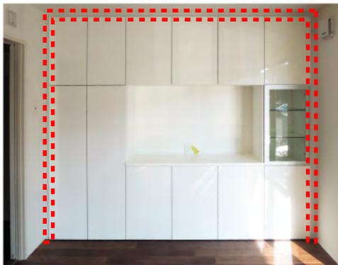
安定した良い品質の収納家具を製作することは勿論のこと、最終的に建築（壁・天井）と一体化した時の収まりにこだわりを持っているので少し短い寸法で家具を製作し、あらかじめ大きめに作ったフィラーを用意して現場でフィラーを削り家具と壁の間に嵌め込みます。
